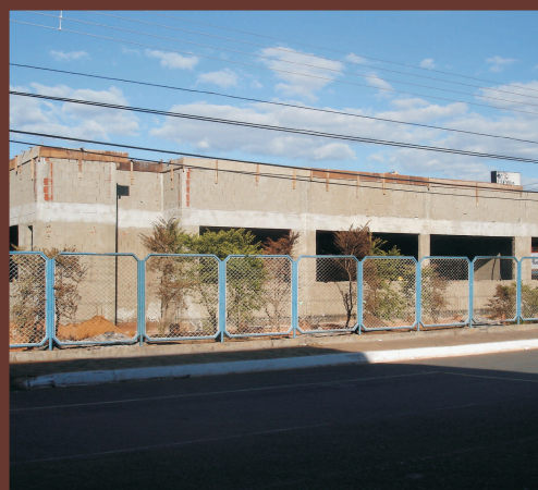
Vista geral da obra 5º Juizado Especial Cível
