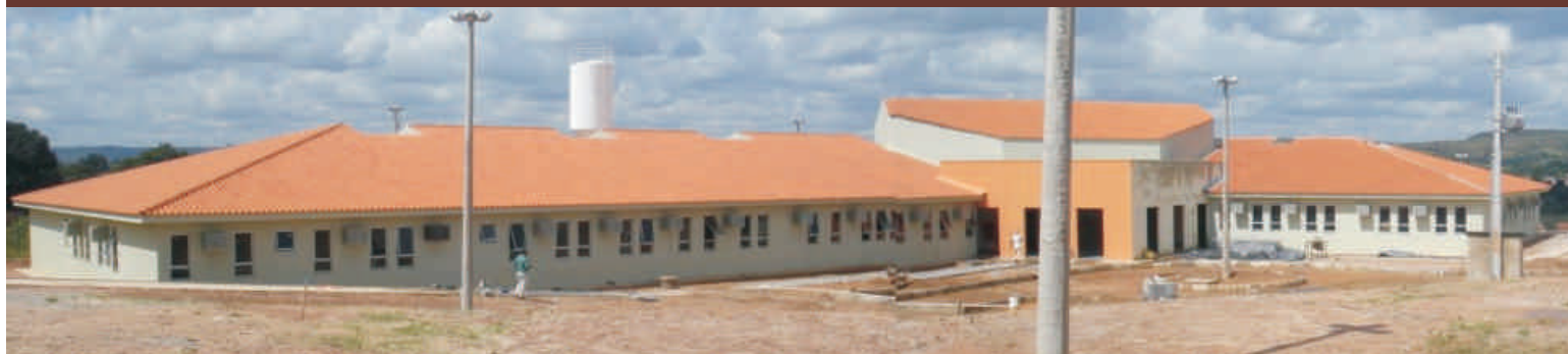
Vista Externa da edificação – Fórum da Comarca de Santo Antônio do Descoberto.
