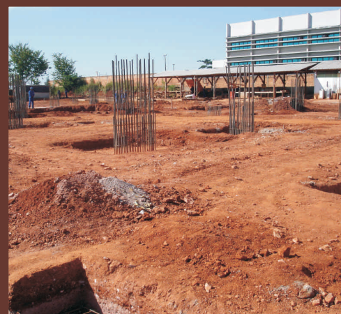
Fundação concluída Fórum Criminal
